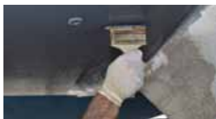
Pincelar ao de leve com trincha, na direcção oposta
