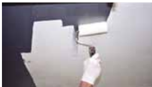
Aplicação de anti-incrustante sobre primário ou selante
