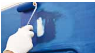
Aplicação de primário em zonas pontualmente reparadas
