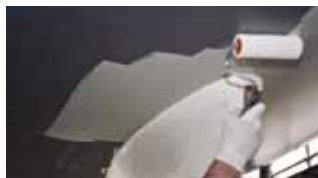
Aplicar anti-incrustante sobre o primário
