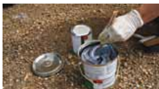
Mexer bem a mistura dos dois produtos
