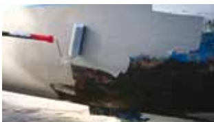
Aplicação de Underwater Primer sobre a superfície tratada
