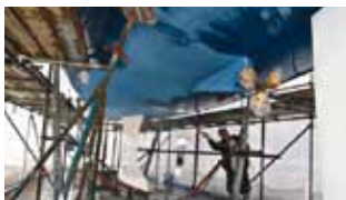
Limpeza da superfície depois de lixada
