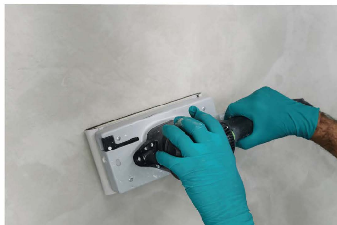
Proceder à lixagem da camada final com lixa de grão 220
