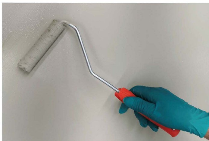
Aplicação de uma demão de Primário MicroDecor à cor
