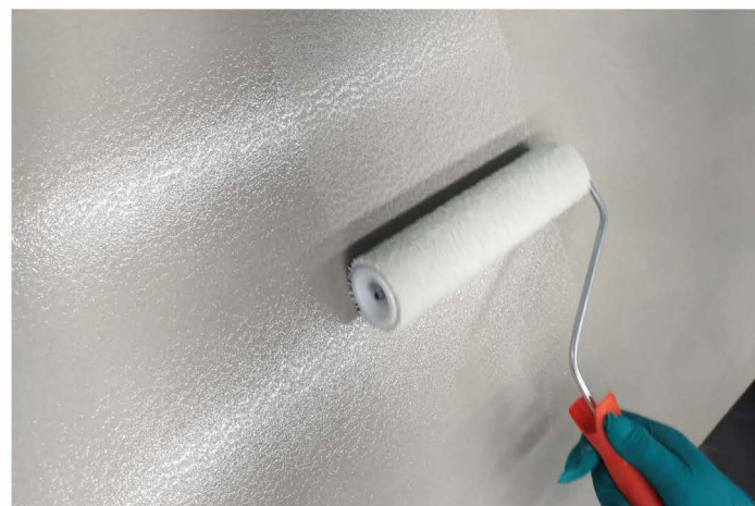
Aplicação de 2 a 3 camadas de Verniz PU 2-Floor 10-920 Mate
